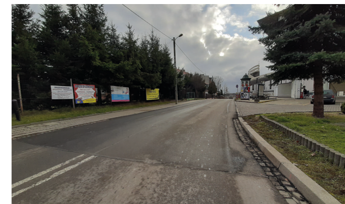
Wyremontowana ul. Faustyny
