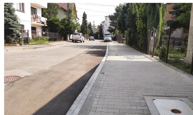
Wyremontowana ul. Uroczą
