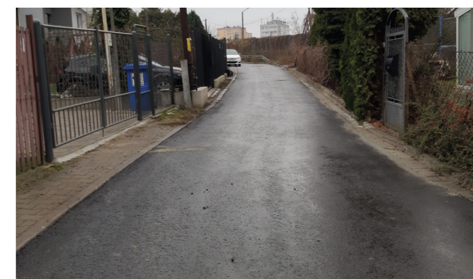
Wyremontowana ul. Malutka
